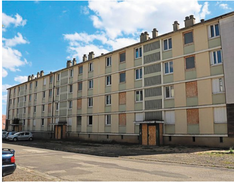
Le premier immeuble, dont la déconstruction a commencé hier. | PHOTO: QUEST-FRANCE
