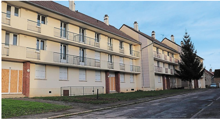
La démolition de 24 logements collectifs de la résidence située chemin des Près, interviendra le 26 février.
