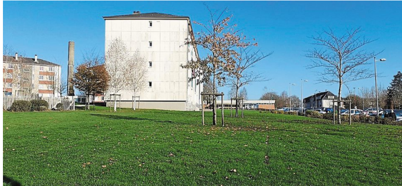
Les travaux du jardin partagé commenceront jeudi.
