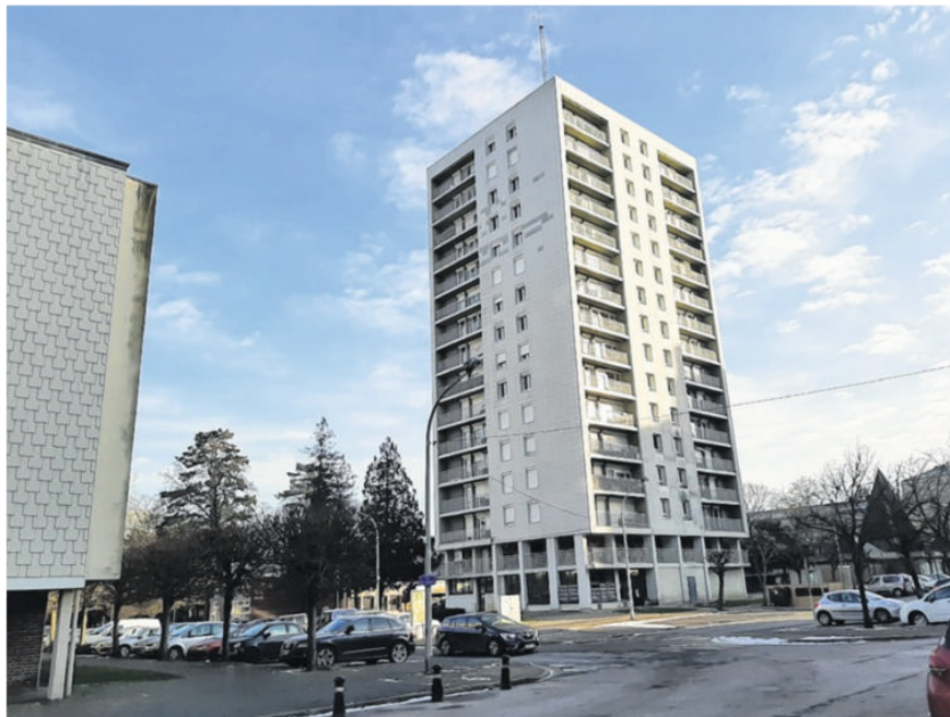
La tour de la rue Taunton appartient à la Sagim. Un permis de démolir a été déposé.
