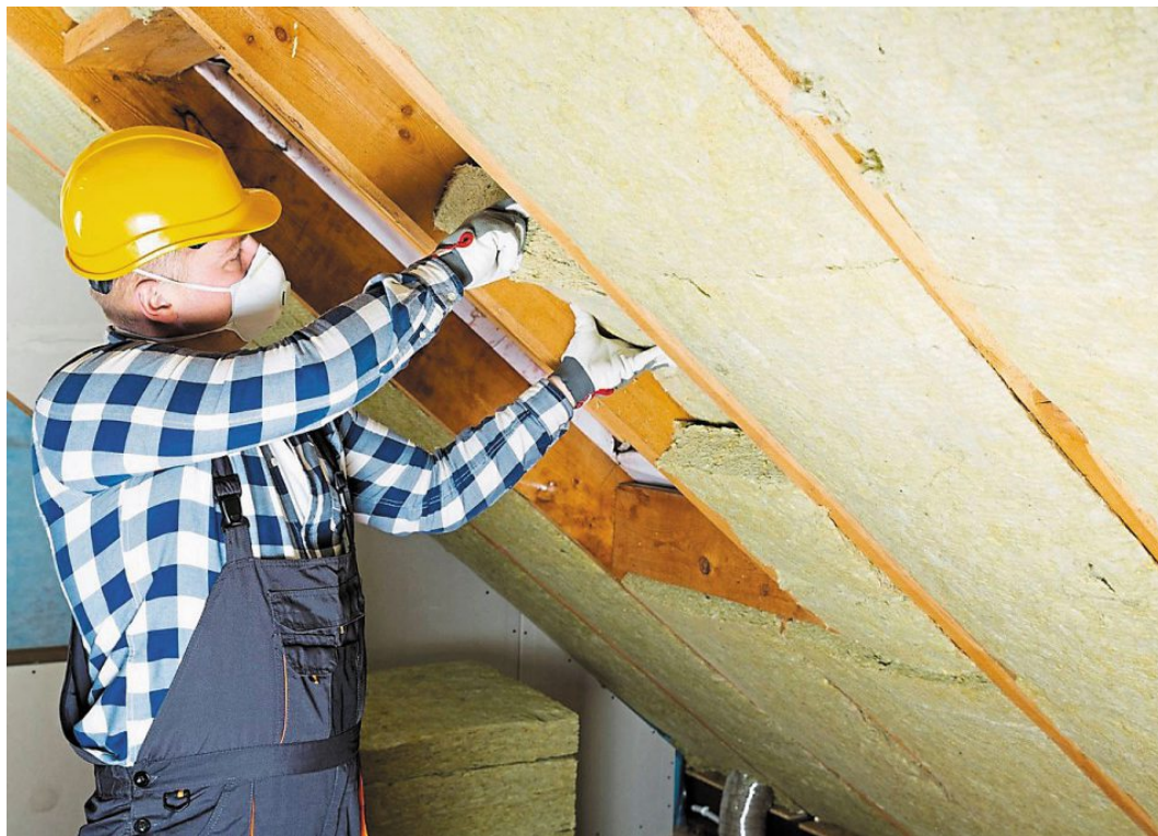
Les charges des logements énergivores sont un frein pour beaucoup de locataires.
